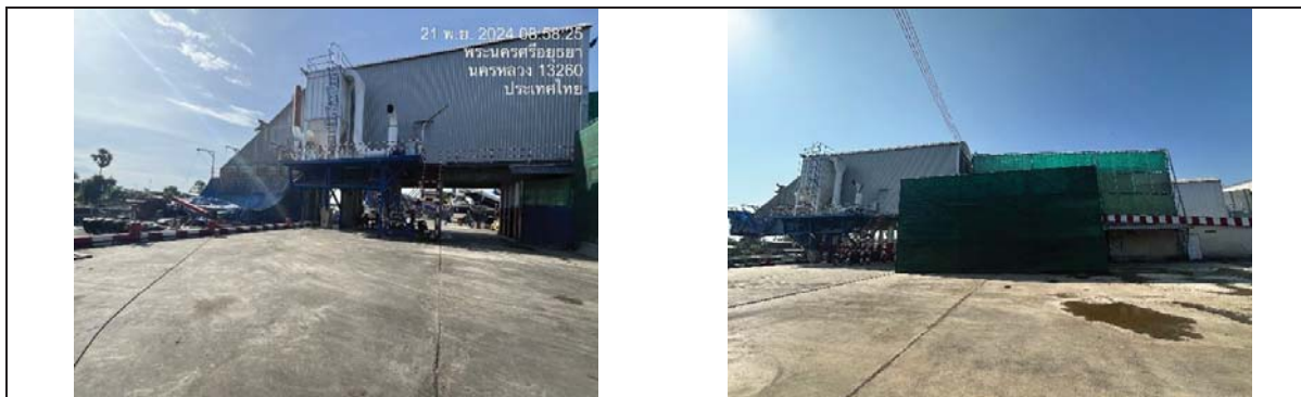
รูปที่ 2-5 เครื่องตักจับฝุ่น และตาข่ายกันฝุ่นบริเวณโรงกลั่นสินค้า A
