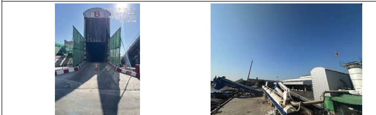
รูปที่ 2-6 เครื่องตักจับฝุ่น ตาข่ายกันฝุ่นบริเวณโรงกลั่นสินค้า B และท่อดูดฝุ่นจากสายพานลำเลียงมันเส้น
