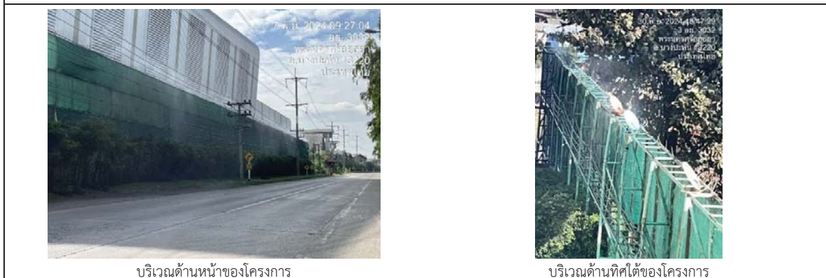
รูปที่ 2-7 ระบบสเปรย์น้ำตามแนวโครงสร้างสแลน
